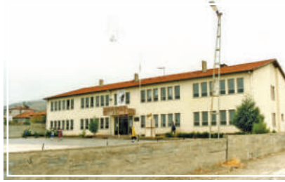
Burdur YSD İlköğretim Okulu 1991
