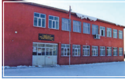
Diyarbakır, Eğin Bahşiler Köyü Atatürk İlköğretim Okulu 2004
