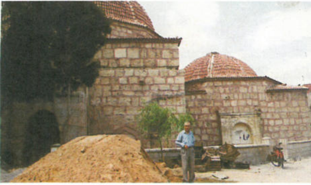
Bor Şubemizce restorasyonu yaptırılan eski hamam...
