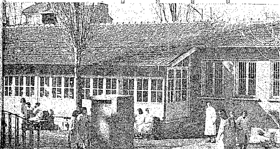
Sıslı Rehabilitasyon Merkezi binası: The Sıslı Rehabilitation Central
